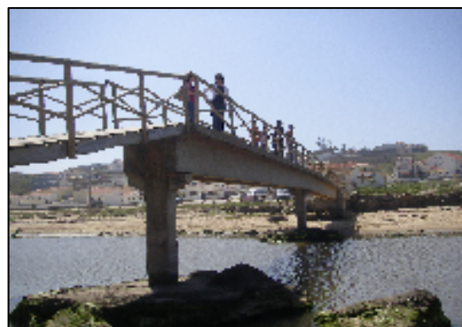
Ponte na Foz do rio Sizandro
