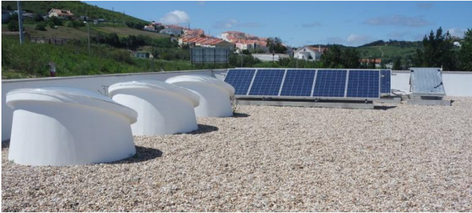
Imagem 4 Painéis Fotovoltaicos e Clarabóias no exterior do edifício
