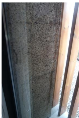
Imagem 2 Revestimento de cortiça
